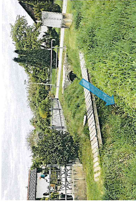
Auslauf der Bachverrohrung
