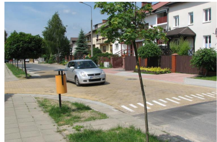
Bsp. Aufpflasterung im Einmündungsbereich https://de.wikipedia.org/wiki/Aufpflasterung
