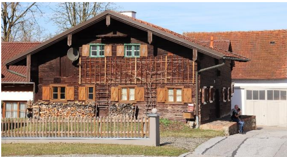
Tropfhaus (Kleinhaus), Erdgeschossiger Blockbau mit Flachsatteldach und Kniestock, 2. Hälfte 17. Jh.
