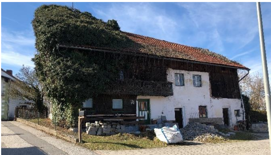
Wohnstallhaus, zweigeschossiger, teilweise ausgemauerter Blockbau mit Satteldach und Traufschrot, 1. Hälfte 19. Jh.
