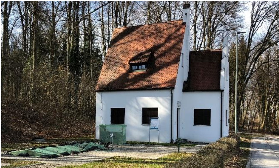
Wasserwerk Osterhofen, 1908; Dazugehöriges Pumphaus, eingeschossiger und zweiteiliger Putzbau mit hohem Satteldach und Treppengiebel.
