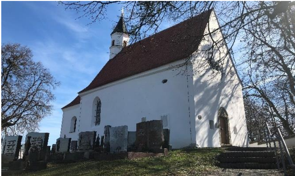
Kath. Filialkirche St. Martin am Angerlberg; spätromanischer Saalbau mit eingezogenem Chor und Dachreiter, 1304 über älterem Kern; mit Ausstattung; Friedhof, ummauert, mittelalterlich.
